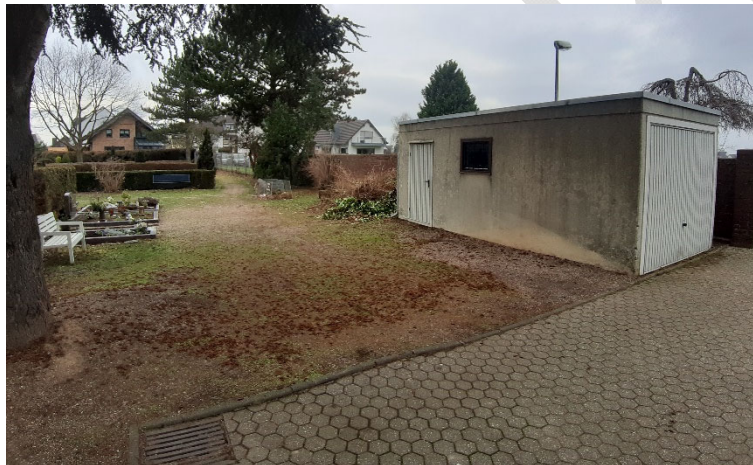
Abbildung 3: Geräte-Garage: Neuer Anstrich und Verlagerung Lagerfläche
